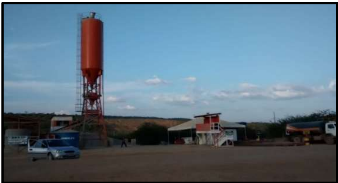
Figura 14 – Canteiro de Obras – Povoado de Boa Vista.
