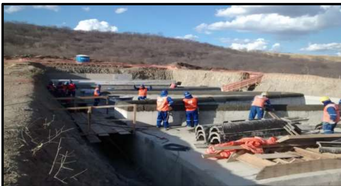
Figura 15 – Operários em Atividade – Construção do Dique Pereiros.
