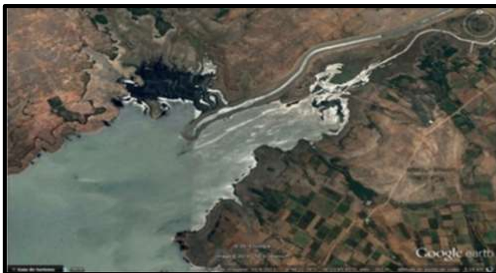
Figura 02 – Ponto de Captação do Eixo Leste 2 .
